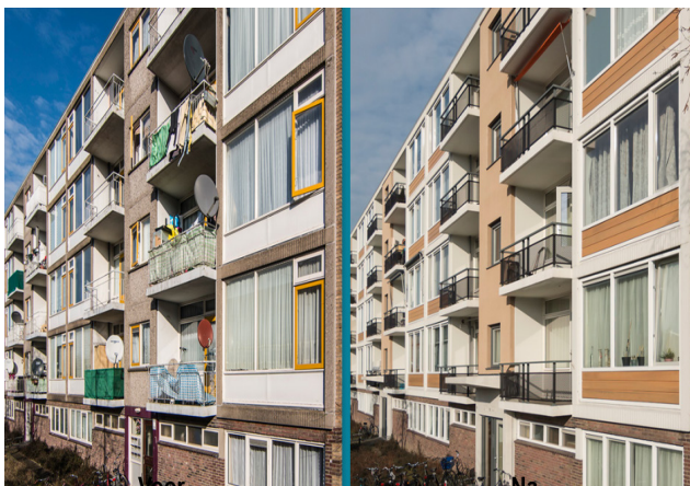
Figuur 3: De renovaties die Bo-Ex aan het verrichten is.
